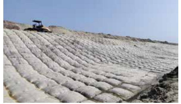
चित्र-2. केनाल स्लोप की रक्षा के लिए संस्थापित किए गए आर्टिकुलेटिंग ग्राउटेड कंक्रीट मैट्रेस का चित्र
