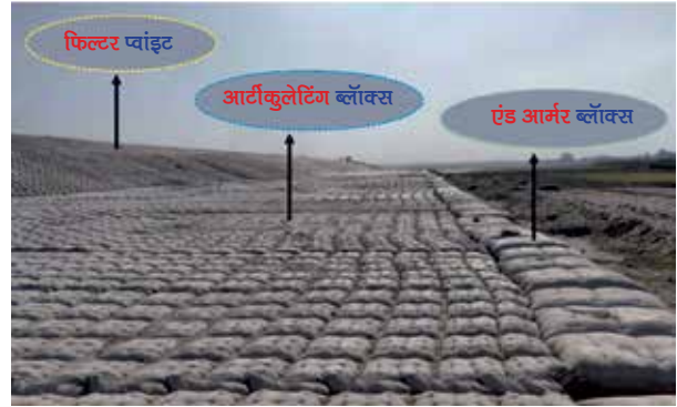
चित्र-7 - संस्थापित किए गए आर्टिकुलेटिंग ग्राउटेड कंक्रीट मैट्रेस के भागों को दर्शाते हुए चित्र
