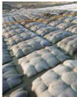
(ख) कंक्रीट फिलिंग के बाद संस्थापित आर्टिकुलेटिंग ग्राउटेड कंक्रीट मैट्रेस दर्शाता चित्र
