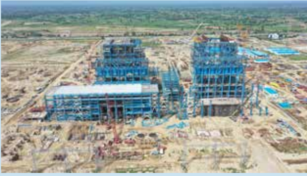
1320 मेगावाट के एसटीपीपी में बॉयलर-1 एवं 2, एमपीएच-2 एवं 2 का उत्पादन एवं सीसीआर भवन का कार्य प्रगति पर
