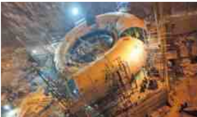
टिहरी पीएसपी (4x250 मे.वा.) के यूनिट 5 में उत्थापन कार्य प्रगति पर
