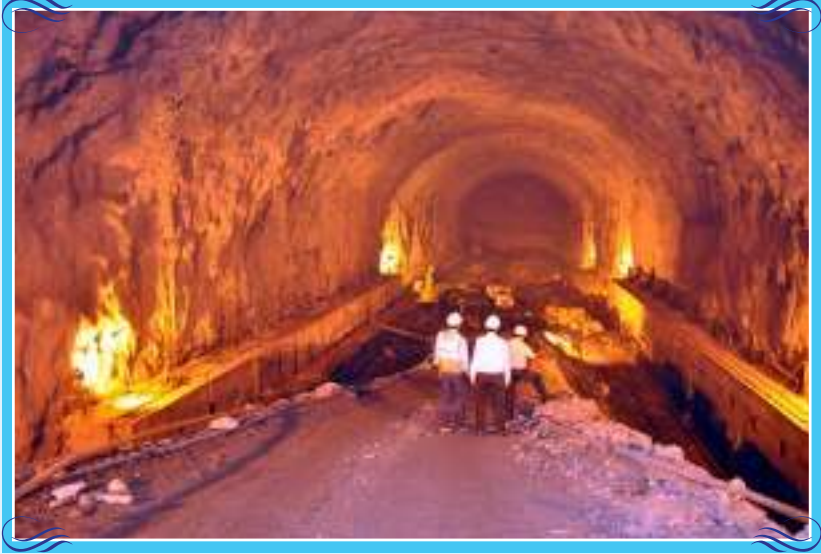
1000 मेगावाट टिहरी पीएसपी का भूमिगत निर्माण कार्य प्रगति पर
