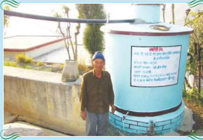
टिहरी बांध जलाशय के समीप गांव में जल संरक्षण हेतु वर्षा जल संग्रहण टैंक
