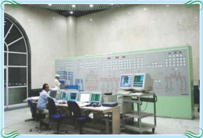
टिहरी एचपीपी के भूमिगत पावर हाउस की कंप्यूटरीकृत नियंत्रण प्रणाली
