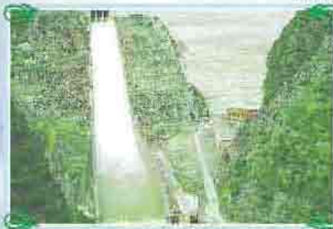
टिहरी गंधर्व का निर्माण
