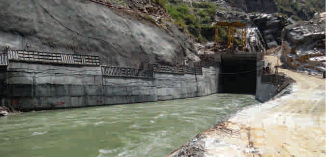
विष्णुगाड पीपलकोटी एचईपी (444 मेगावाट) में 02.04.2018 को डाइवर्जन सुरंग के माध्यम से अलकनंदा नदी का मार्ग परिवर्तन
