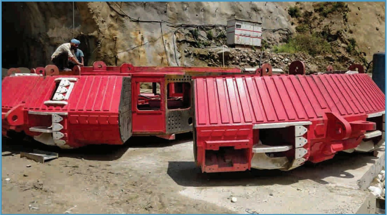
विष्णुगाड पीपलकोटी एचईपी (444 मेगावाट) में टनल बोरिंग मशीन की असेम्बली प्रगति पर
