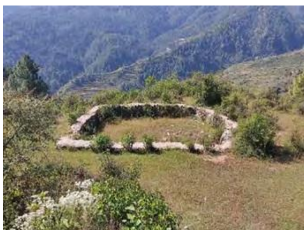
चित्र 5.3: परियोजना स्थल पर निर्मित चाल खाल
